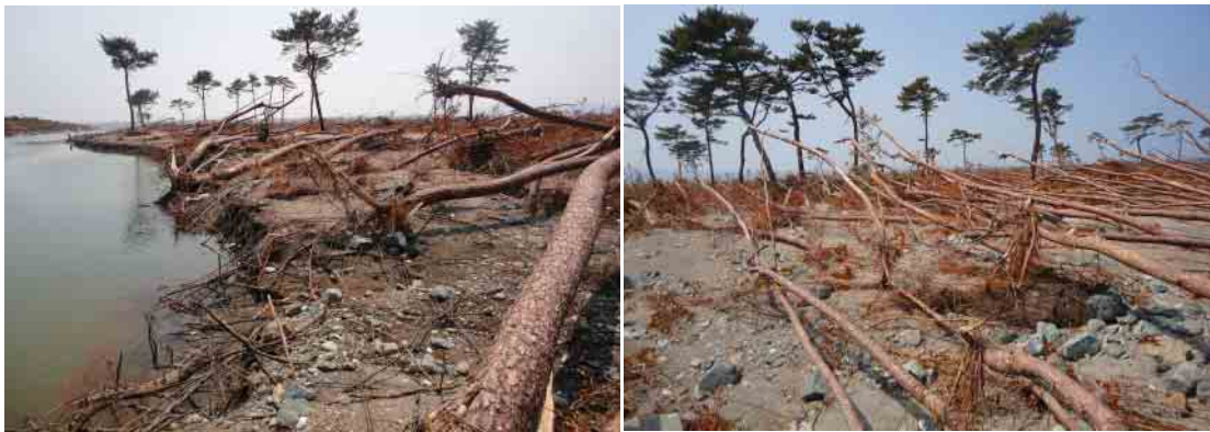
防潮堤の背後では、大規模な落掘が発生、幅 40~50m にも及ぶ水路が形成されている。 落掘とその背後のマツ林。福島県相馬市松川浦芹谷地海岸
